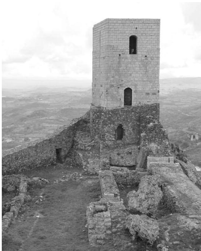
Castello di Osilo, torre quadrata (foto di Franco Campus)
